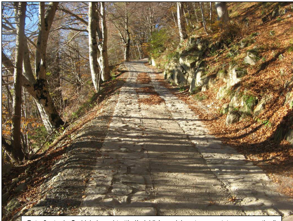
Foto 2: strada Geridol che nei tratti più ripidi è parzialmente cementata per garantire il transito in sicurezza dei mezzi forestali.
