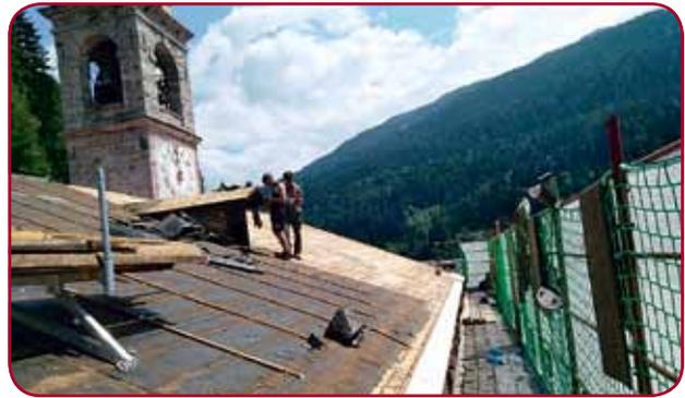
sopra delle strutture portanti e del tavolato è stato realizzato con la messa in opera di una guaina traspirante, della stuoia antirombo e del nuovo manto di copertura realizzato in lamiera di rame da 8/10 di mm, aggrappato al sottostante tavolato secondo le tecniche di lavorazione tradizionale.
